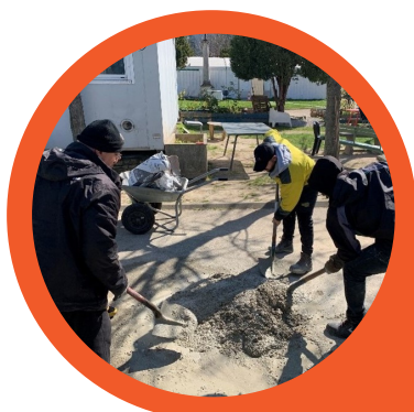
DALLE DE BÉTON À L'ESI SAINT-MICHEL
